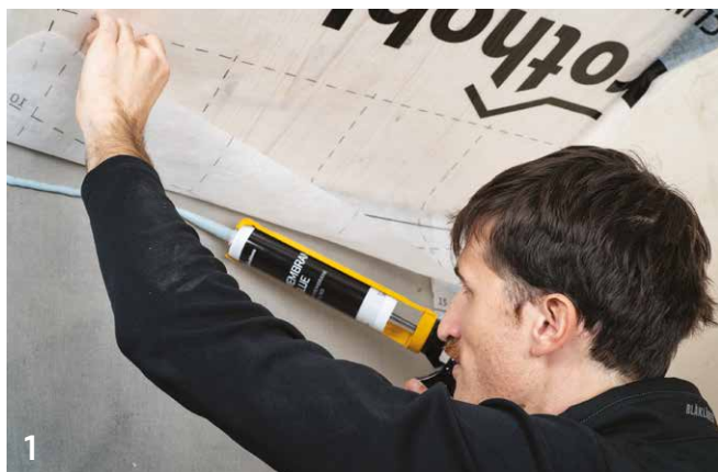
지붕과 멤브레인 접합부 - 콘크리트
